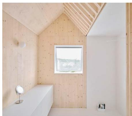
ster und Raumgeometrie großzügig. „Unsere Leitidee war ein nachhaltiges Haus umzusetzen. Zum einen trägt der Holzbau und Holzweichfaserdämmung dazu bei, zum anderen das alles roh belassen wurde und viele Schichten weggelassen wurden“, erläutert Architekt Marc Flick. (Beteiligte Gewerke/Hersteller siehe S. XYZ)
