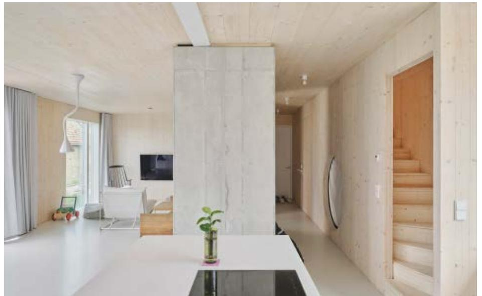
roh belassen wurden: Neben der hervorragenden Energiebilanz leistet das Brettsperrholz auch einen Beitrag zum Raumklima. Und kostensparend ist es außerdem. Die Konstruktion ist simpel und kam mit bereits fertiger Oberfläche auf die Baustelle. Der Keller besteht nur aus Beton und wurde kalt gelassen. Wie bei vielen Häusern auf dem Land gehört er nicht zur thermischen Hülle und ist nur von außen begehbar.
